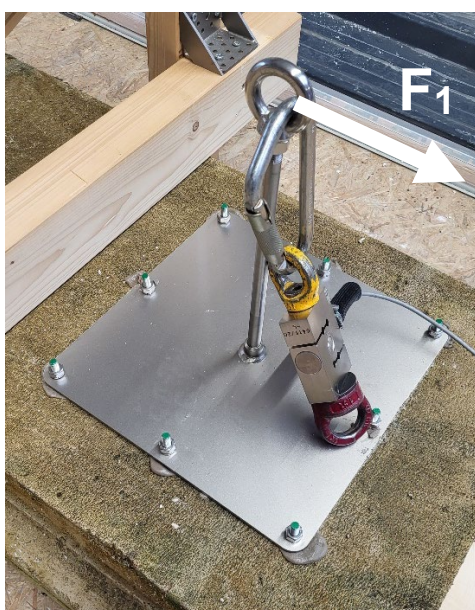
Bild 25: Prüfaufbau 3, Anschlagereinrichtung, Typ: ABS-Lock X-Y
